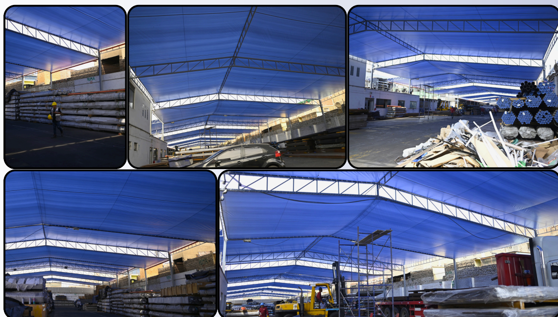
Cobertor de tarflex para techo de estructura metálica en almacén de Polimetales S.AC. Tamaño de cobertura: 1000 m 2
