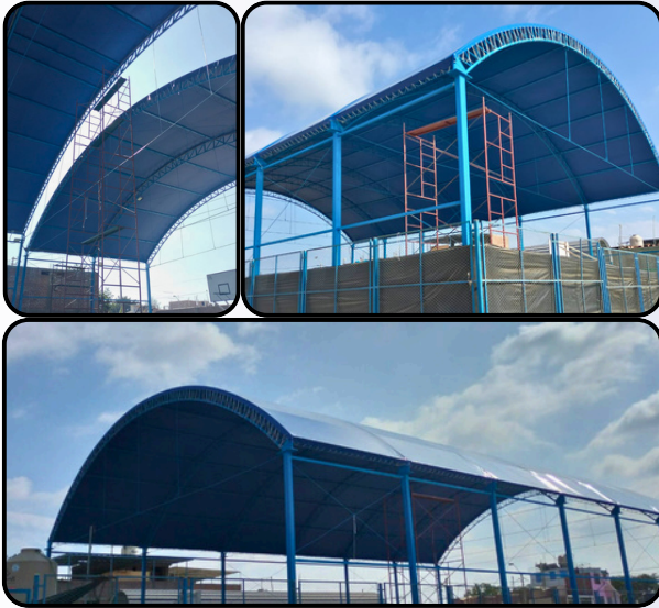
Techado de cancha deportiva municipalidad de Ica Tamaño de cobertura: 1200 m 2
