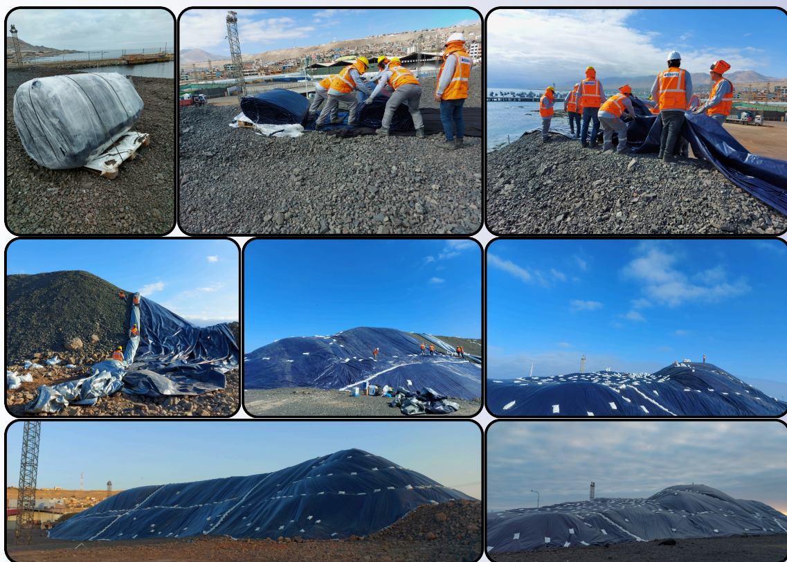
Cobertor de tarflex para la protección y contención de escoria de cobre en ENAPU S.A. Tamaño de cobertura: 15064 m 2
