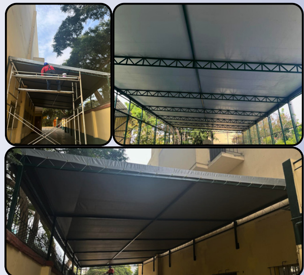
Techado de área exterior Colegio Santa Ursula, San Isidro, Lima
