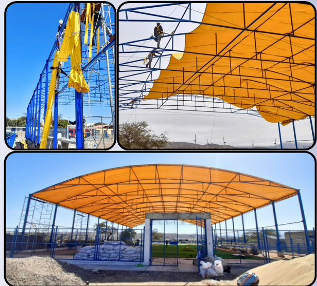
Techado de cancha deportiva municipalidad de Changuillo Tamaño de cobertura: 1248 m 2
