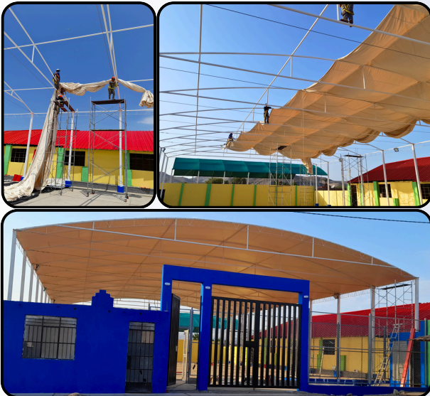
Techado de cancha deportiva municipalidad de Nazca Tamaño de cobertura: 1080 m 2
